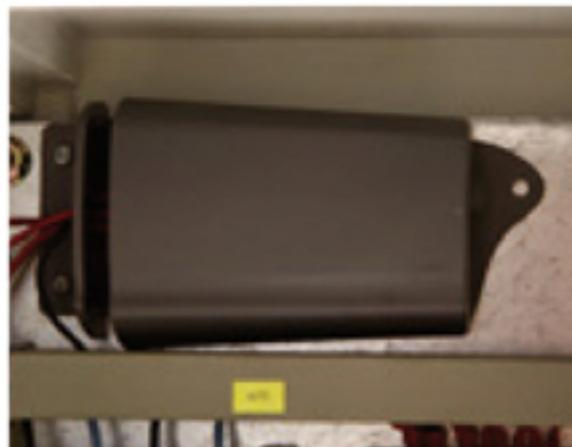
Sacar la tapa deslizando la carcasa hacia la derecha.
